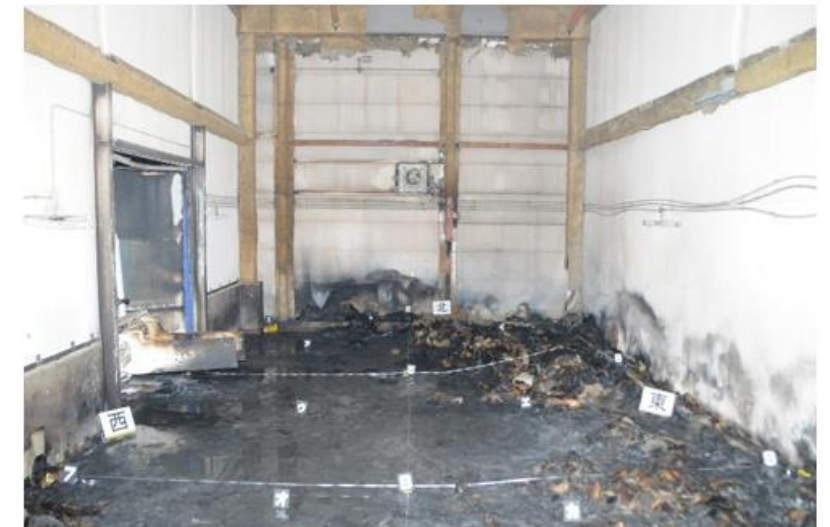
②【端材室内(北側)】
