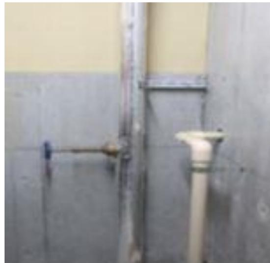
水道直結型SPの停止弁
