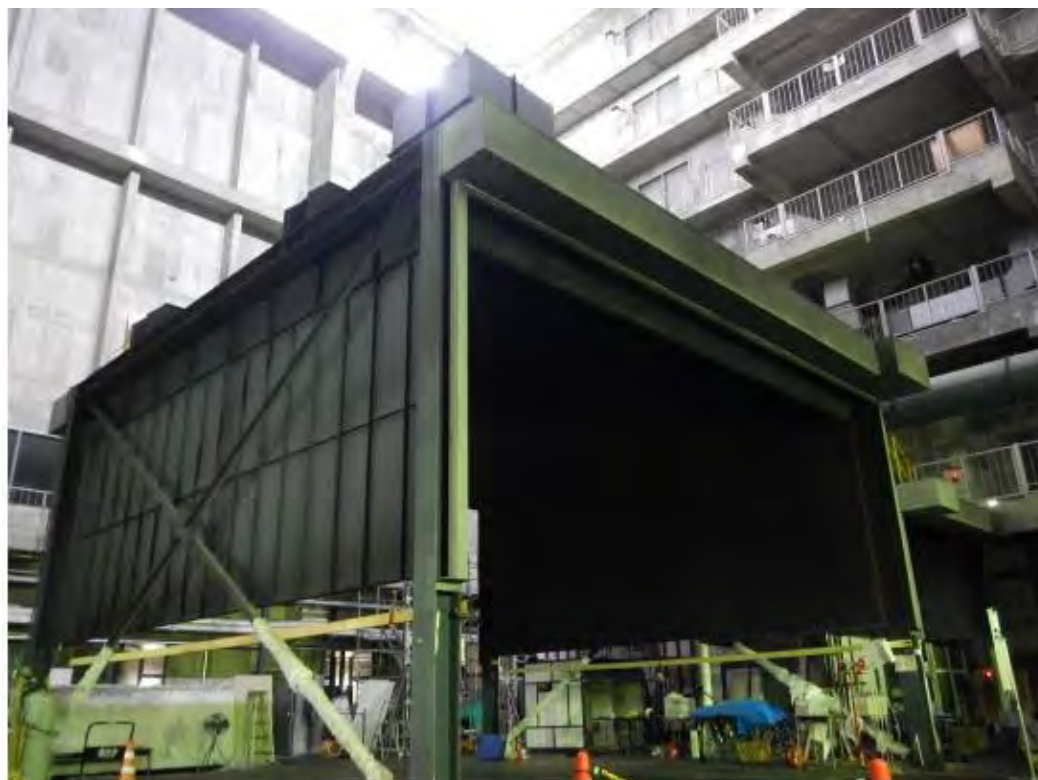
写真 建築研究所（8mフード）
