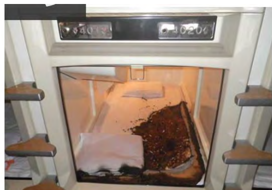
写真 6 マットレスの焼損状況
