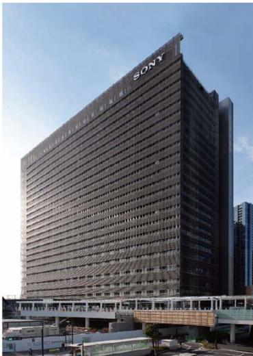
この建物は、120mの長さの無柱の執務空間を特徴とするオフィスビルで、避難の歩行距離の緩和を目的として避難安全検証を適用しています。建物前面にはバルコニーが設置されており、バルコニー端部にある外部階段が補助的な避難経路となっています。執務空間に平行して安全区画された廊下の端部正面に避難階段がある明快な構成も避難安全を高めています。バルコニーにはセラミック製の中空ルーバーを流れる水の蒸発熱で環境負荷を軽減する装置も設置されていました。ちょうど見学の最後に東北地方太平洋沖地震が発生し、免震ビルの有効性を体感することがで
