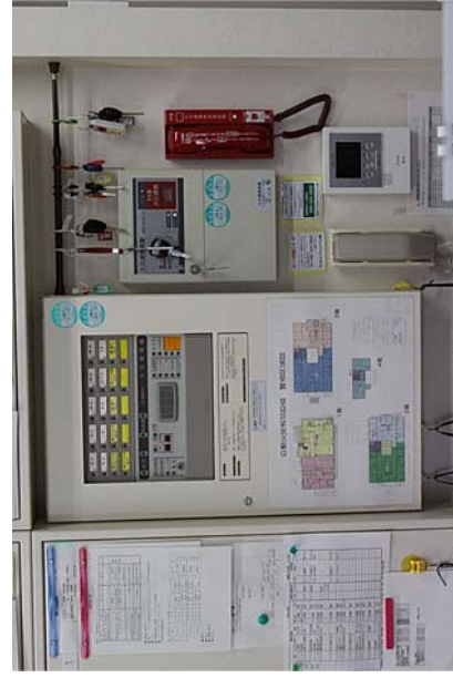
自動火災報知設備 P型1級複合式受信機
