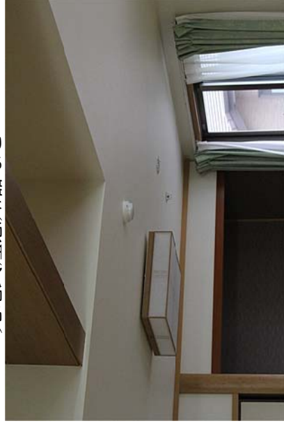
共用部の差動式熱感知器
