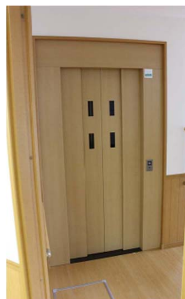
写真11 本館エレベータ扉の状況
