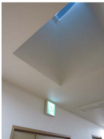
写真7 別館2階共通エリアのトップライト
