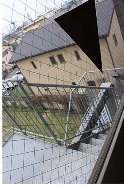
非常用の外部避難階段 (二方向避難の確保)
