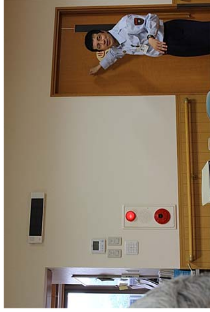
自動火災報知設備用発信機 (火災通報装置と連動なし) 各室出入口 の木製扉
