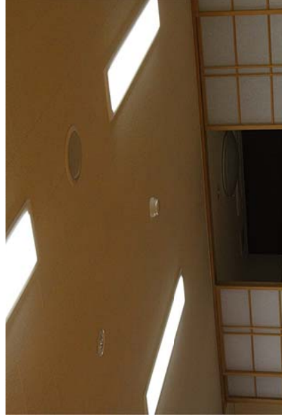
共用部の差動式熱感知器
