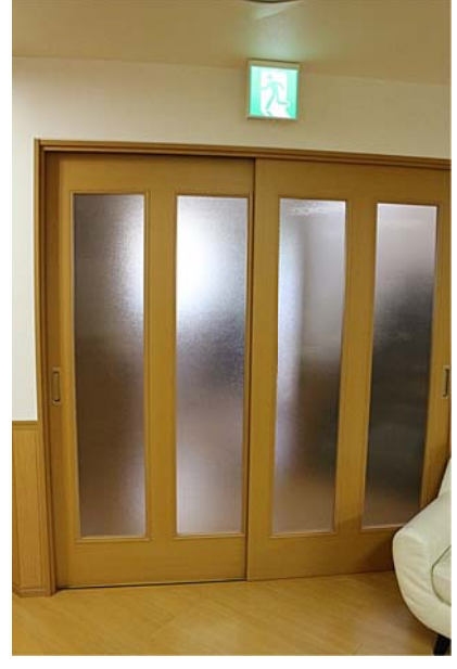
グループホームの玄関 内扉
