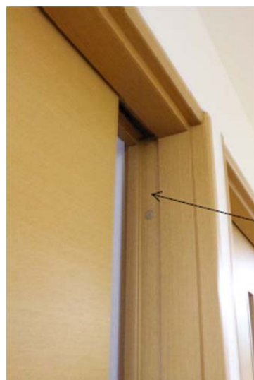
写真 13 個室扉の状況(つり戸に なっているが機密性が良い)
