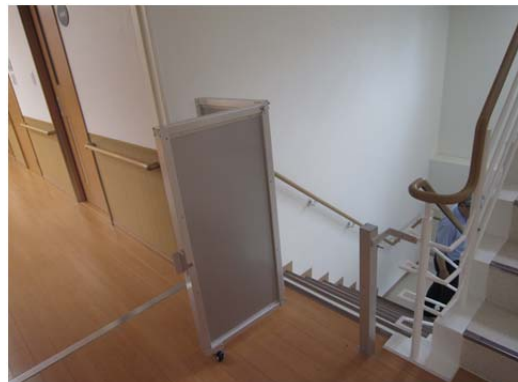
写真 6 急峻な階段と階段前のゲート
