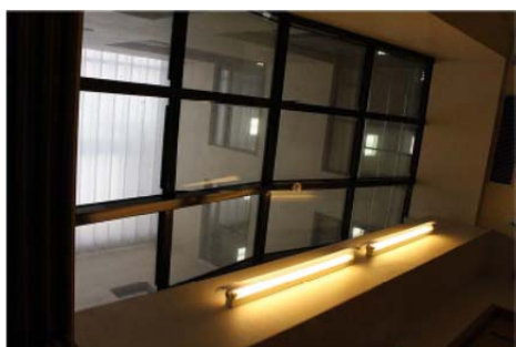
写真9 本館中庭の状況(2階の天井の状況)
