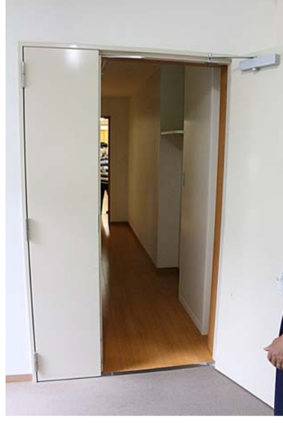
渡り廊下への出入口 防火戸の開放状況
