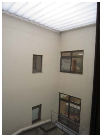
写真8 本館中庭の状況(3,4階の状況)
