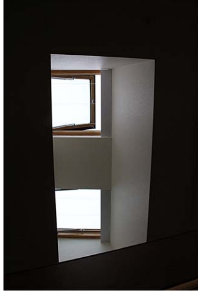
自然排煙口 開放状況
