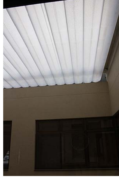
吹き抜け部の上部
