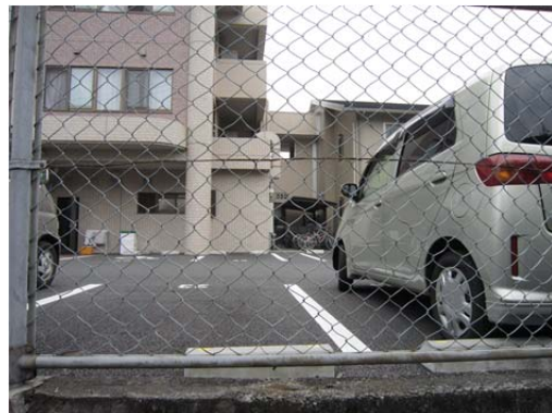
写真 3 両棟の接合部(2階は外部)
