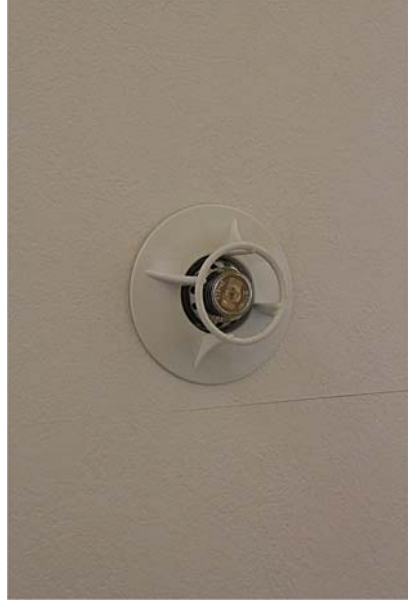
水道直結型スプリンクラーヘッド
